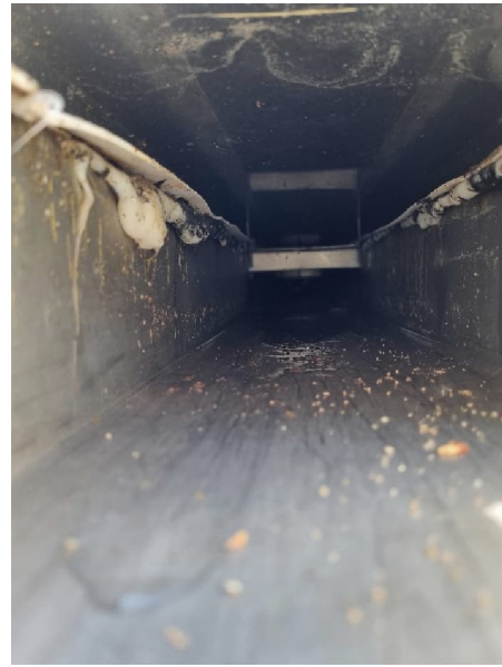
Einströmkanal mit Revisionsöffnung, Einströmkanal von innen, keine vollständige Wartung und Reinigung möglich, Dichtheit nicht gegeben
