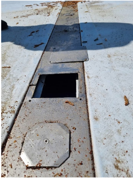
Einströmkanal mit Revisionsöffnung, Einströmkanal von innen, keine vollständige Wartung und Reinigung möglich, Dichtheit nicht gegeben
