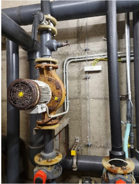
Technikraum: Boden feucht, teilweise Wasser; dadurch Angriff auf Armaturen, Elektronik durch Oxidation
