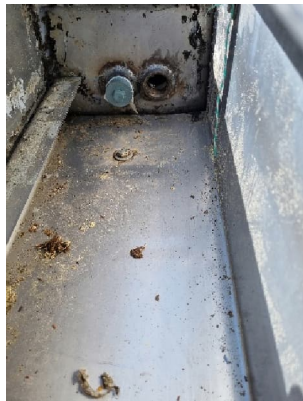
Materialanschlüsse, Lücken im Zentimeterbereich der Überlaufrinne, fehlende Haarfänge, Abdichtungen Anschlüsse, Überlaufrinne nur in Zentimeterbreite dadurch keine Wartung, Reinigung möglich
