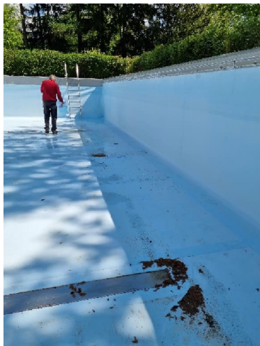
Unebenheiten Schwimmerbecken sowie Einströmkanal. Keine vollständige Durchströmung und Umwälzung möglich > entspricht nicht der Schwimmbadverordnung
