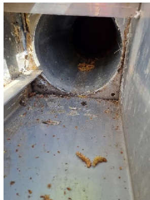
Materialanschlüsse, Lücken im Zentimeterbereich der Überlaufrinne, fehlende Haarfänge, Abdichtungen Anschlüsse, Überlaufrinne nur in Zentimeterbreite dadurch keine Wartung, Reinigung möglich
