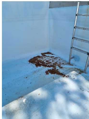
Unebenheiten Schwimmerbecken sowie Einströmkanal. Keine vollständige Durchströmung und Umwälzung möglich > entspricht nicht der Schwimmbadverordnung
