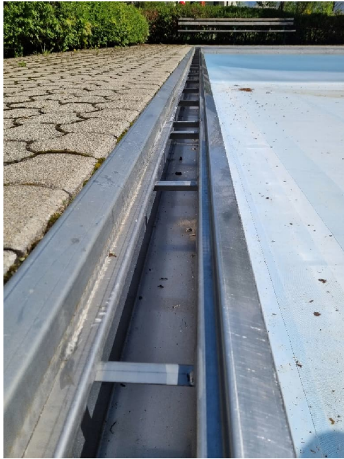
Beckenkopf Überlaufrinne und Anschlussprofile: keine Abdichtung Beckenkopf und fehlerhafte Anschlusssituation
