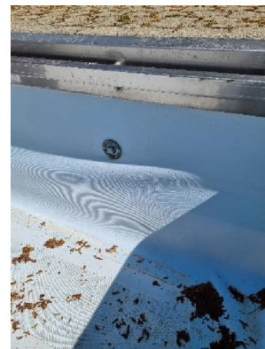
Materialanschlüsse, Lücken im Zentimeterbereich der Überlaufrinne, fehlende Haarfänge, Abdichtungen Anschlüsse, Überlaufrinne nur in Zentimeterbreite dadurch keine Wartung, Reinigung möglich
