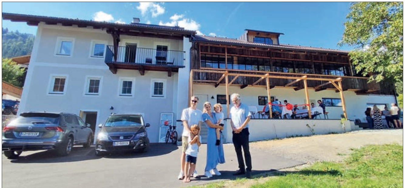
Am 2. September wurde pünktlich zum Dolomitenmann fertiggestellt!
