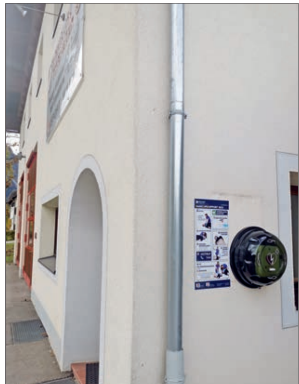
Situierung des Defis am Feuerwehrhaus, mit Bedienungsanleitung.
