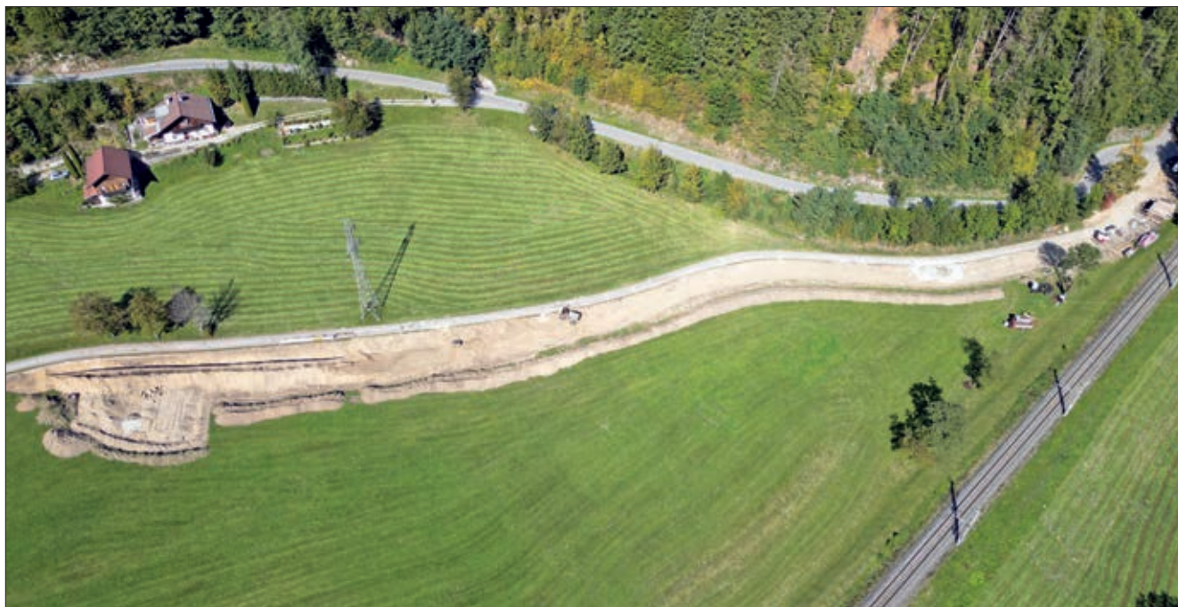
Die Länge der Verbindungsleitung – neben dem Brunnen wird das Druckausgleichsbecken in Betrieb sein. Foto: Herbert Mariacher
