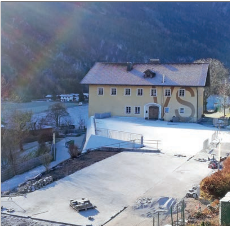
Neugestaltung des Schulvorplatzes.
