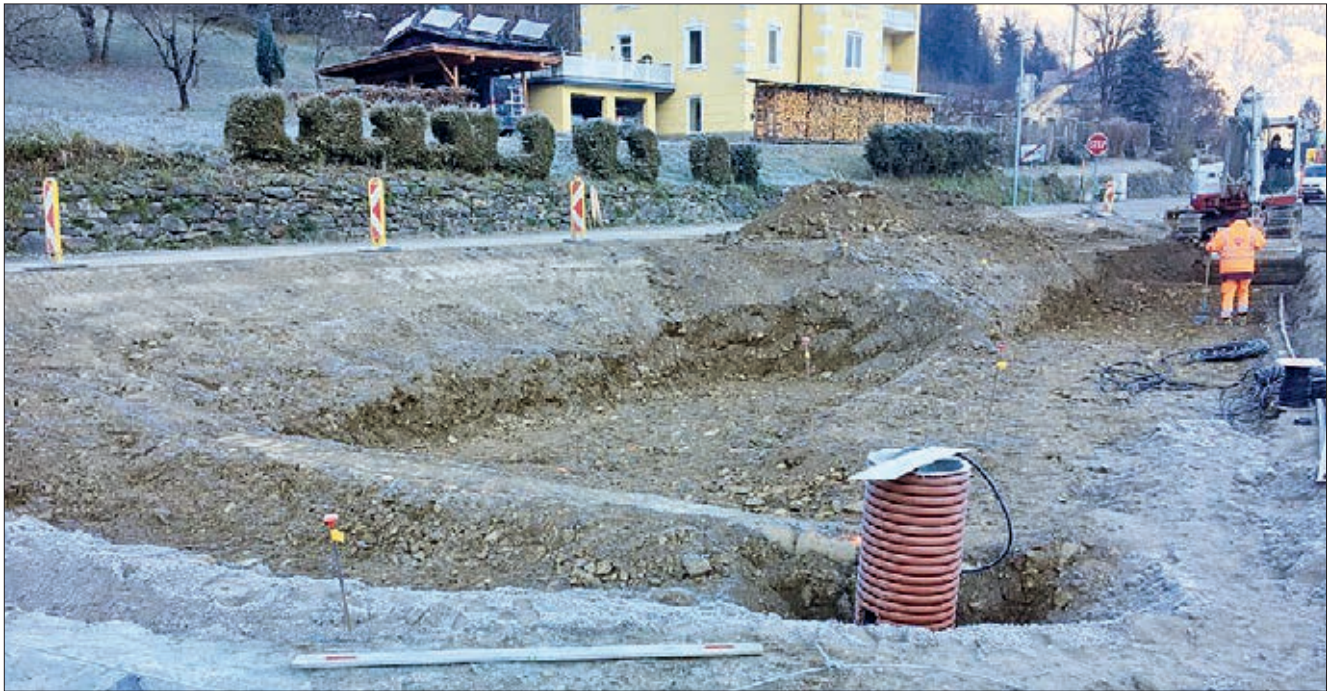
4 Grabungsarbeiten für die neue Bushaltestelle „Alte Straße“.
