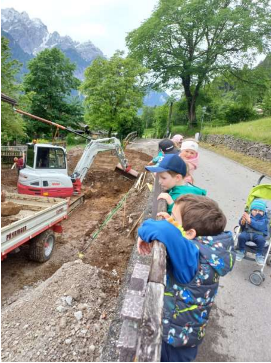
Spaziergang zu einer Baustelle im Dorf
